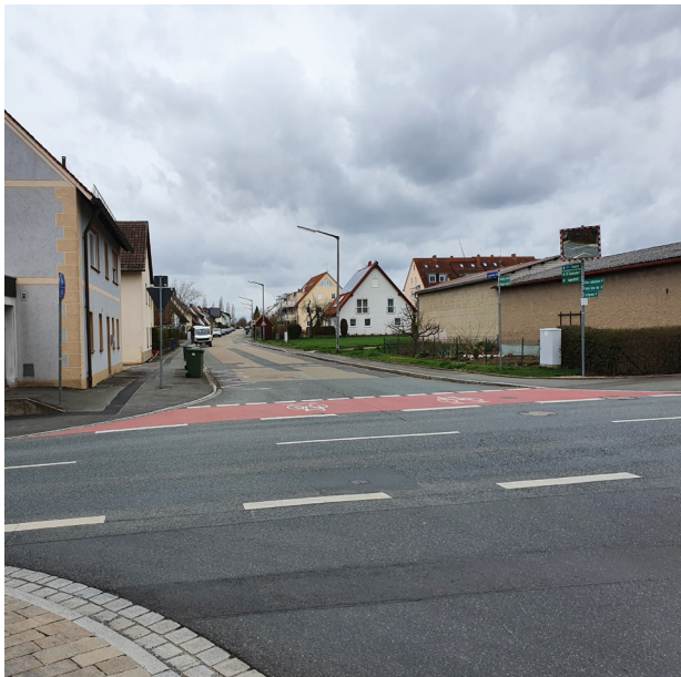
Abbildung 6: Radwegefurt am benutzungspflichtigen Radweg in der Siegeldorfer Straße
